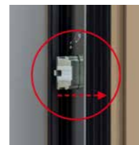
Automatischer Türöffner für Automatikschlösser (A-Öffner)
